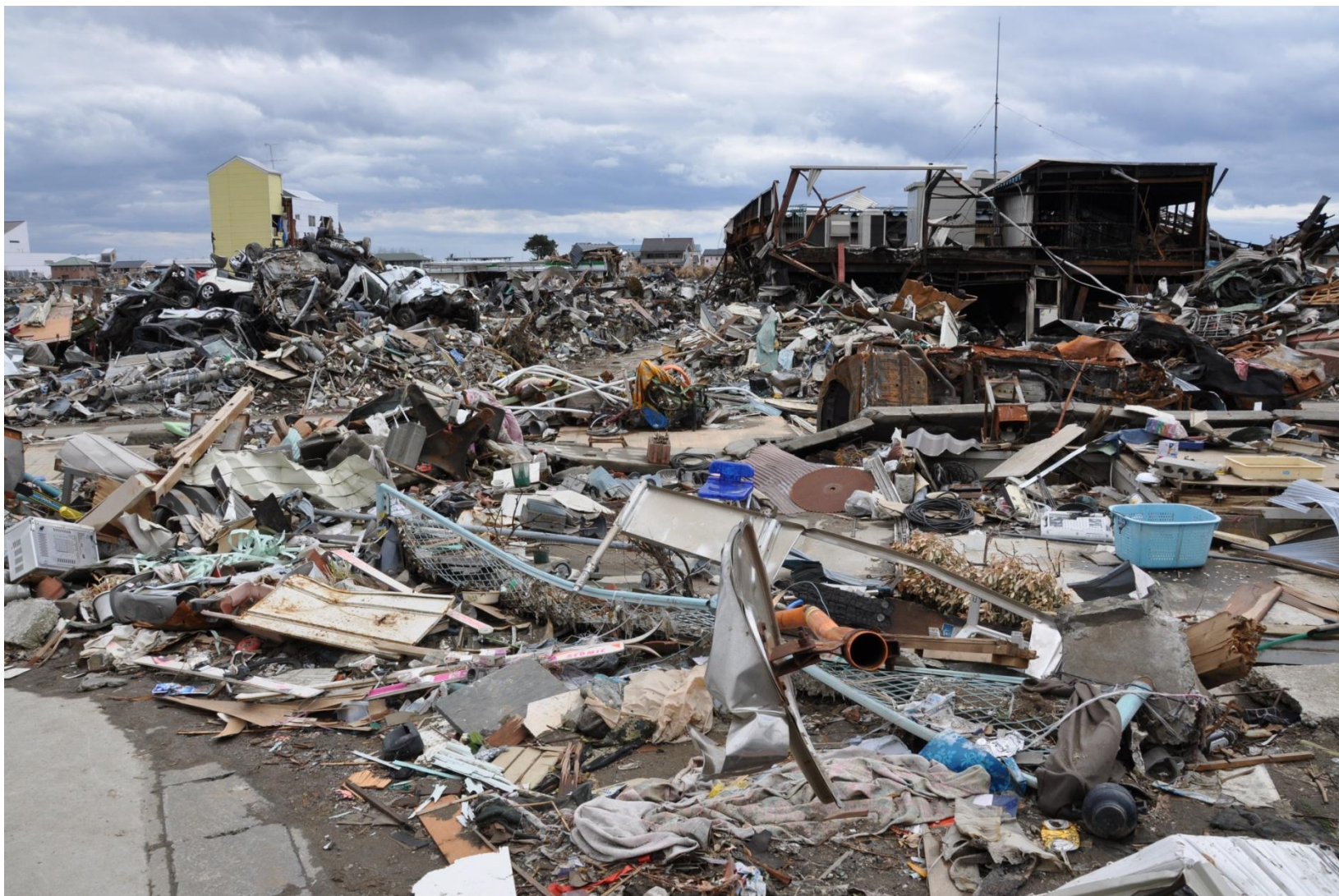
町壊滅。家も車も何もかもがなぎ倒される。 (撮影:2011.4.20 宮城県石巻市門脇町・南浜町)
